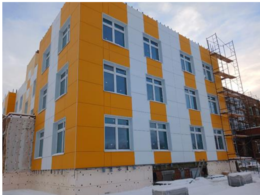
Фотография 28. Строящийся детский сад на 120 мест по ул. Жданова, 30А
