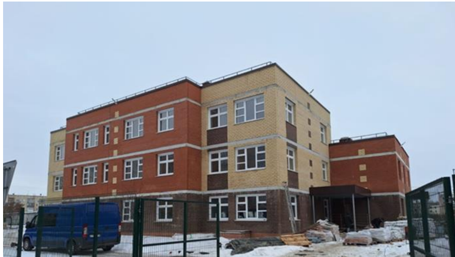
Фотография 27. Строящийся детский сад на 120 мест по ул. 26 Партсъезда, 3Б
