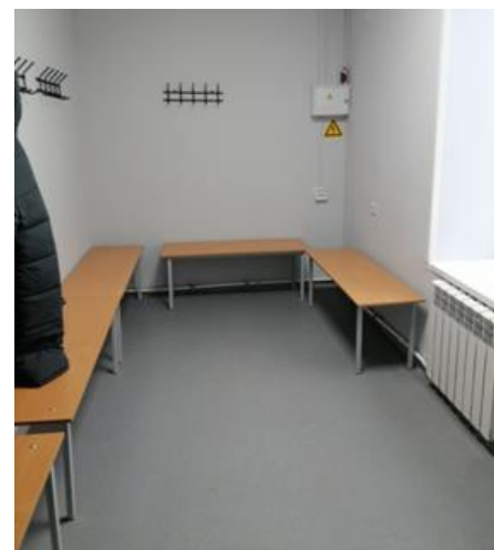
Фотография 55. Ремонт раздевалки МБУ «СШ №3» (п. Потанино)
