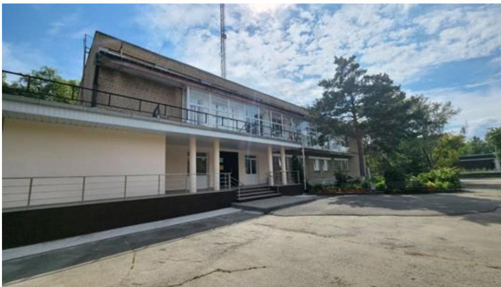
Фотография 39. Капитальный ремонт входной группы МУ «ДК Петрякова»
