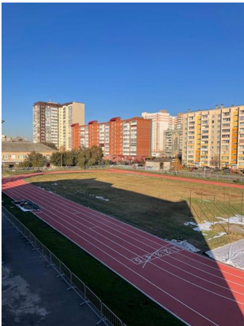
Фотография 50. Ремонт стадиона МБУ «СШ № 1»
