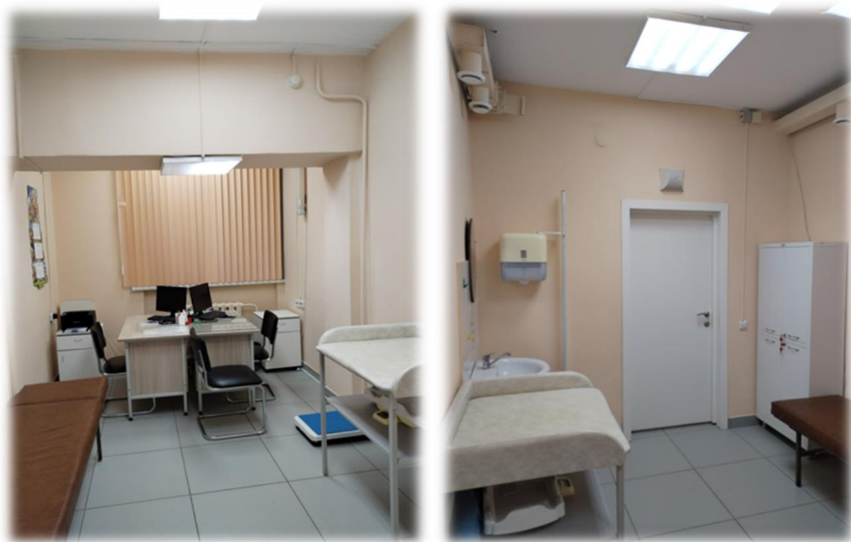
Фото 57-58. Детский неврологический кабинет после ремонта
