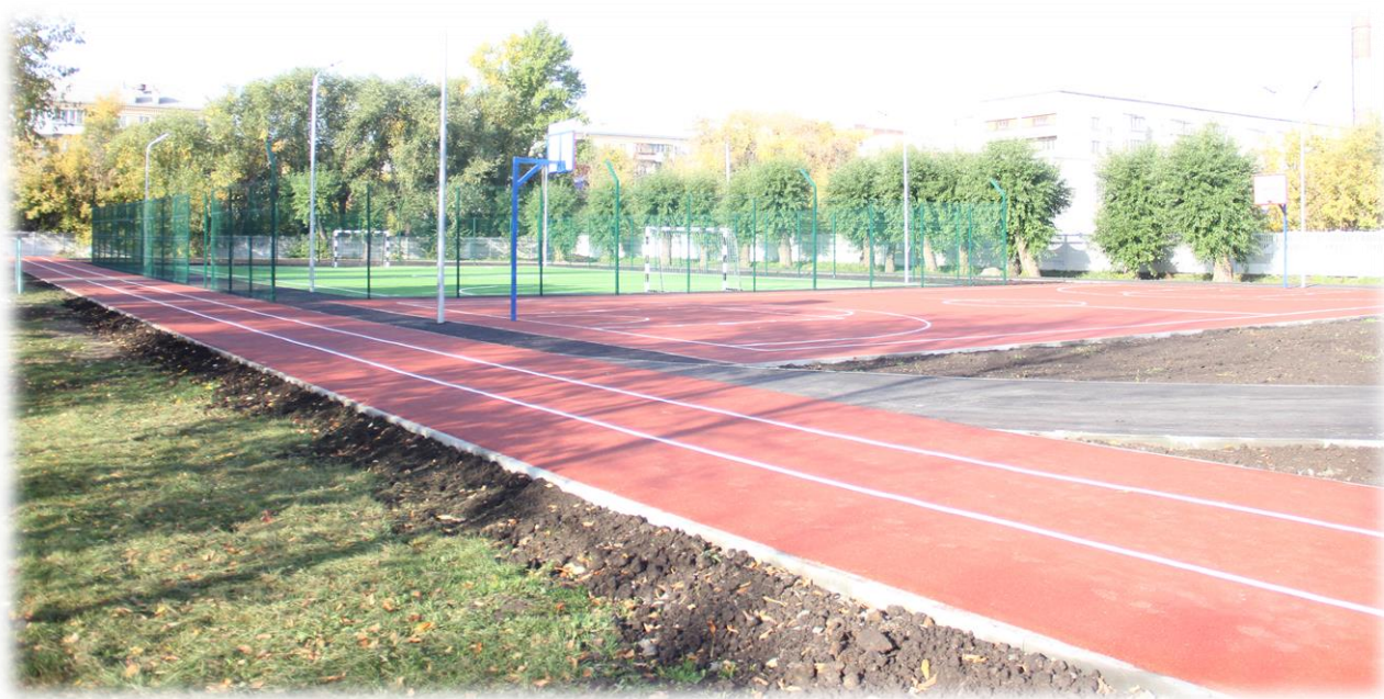
Фото 31. Капитальный ремонт спортивной площадки МОУ «СОШ №42»
