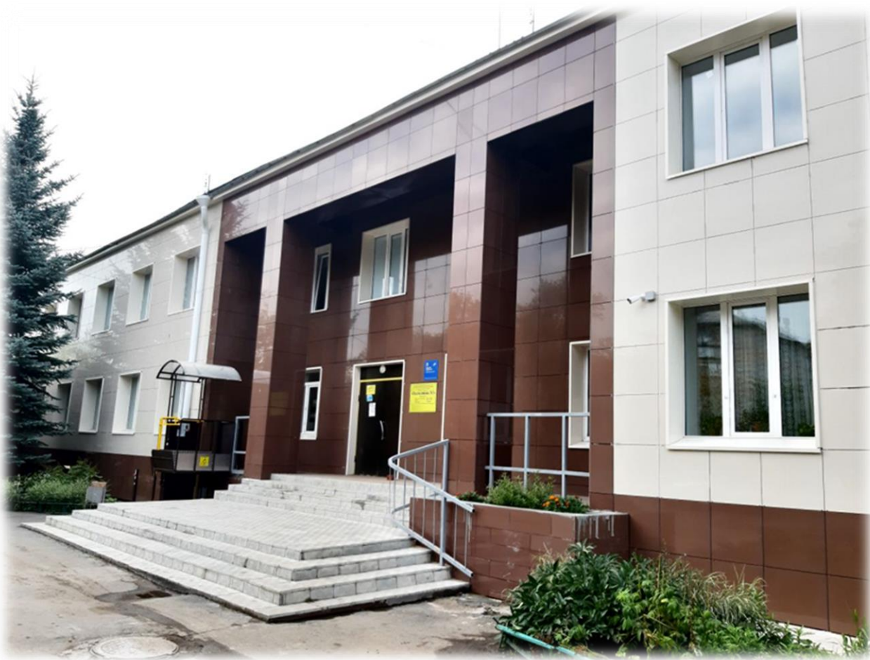
Фото 54. Фасад поликлиники № 3 в Октябрьском жилом массиве после капитального ремонта
